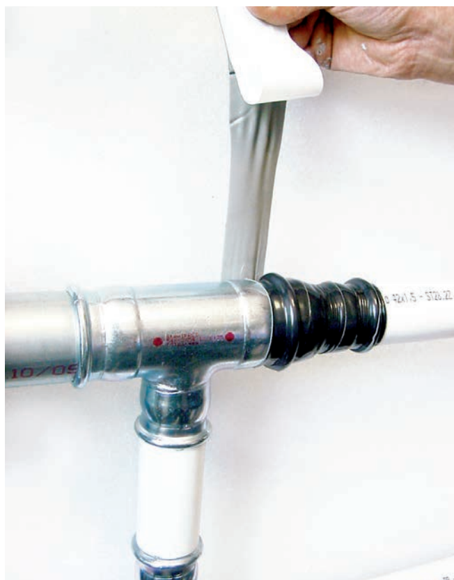
Fig. 43 – Skydd av anslutningar med butyltejp
