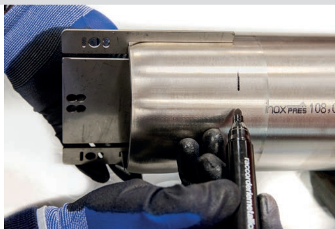
Fig. 29 – Markering av införingsdjupet med hjälp av en märkpenna Ø 76 mm – Ø 88 mm – Ø 108 mm
