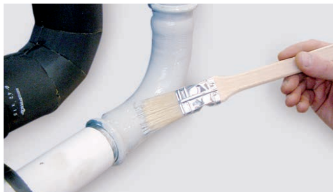
Fig. 42 – Lack på anslutningar och rör med primer
